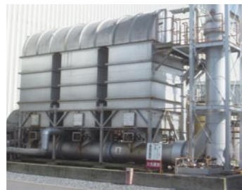
蓄熱脱臭設備
