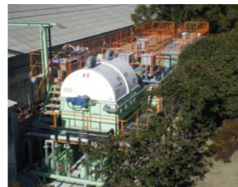
排水処理設備
