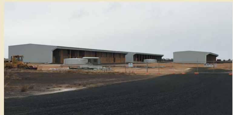
新倉庫(ドゥーン)
